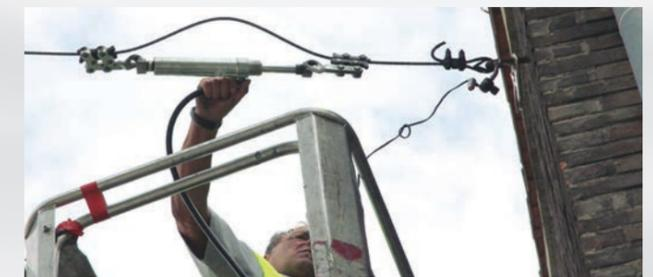
**Merkmal:** Prüfung der Statik durch Zugprobe ohne Fassadenabstützung.
